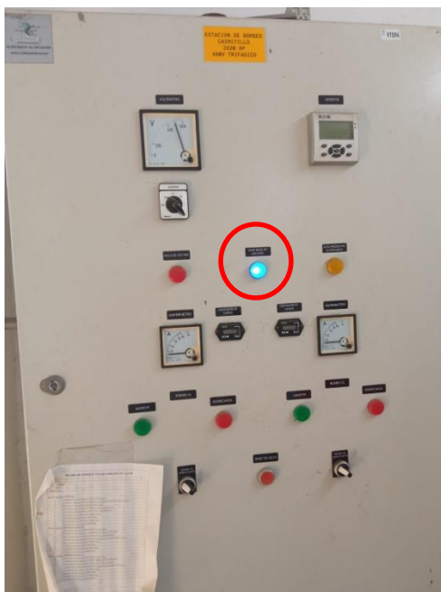
Ilustración 12 Nivel bajo en tanque de succión el día 03 de febrero
