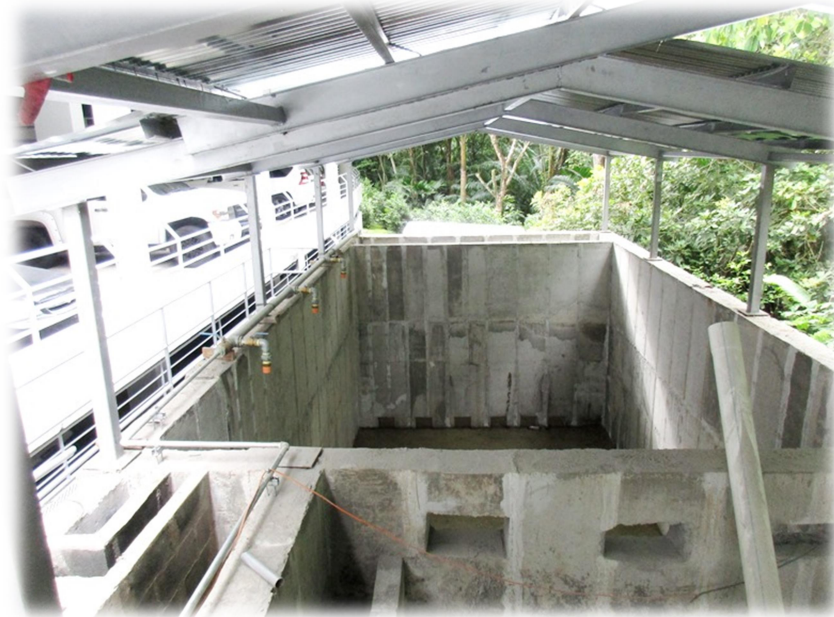
Fotografía 2 Cámara de aireación típica de una PTAR con aireación forzada
