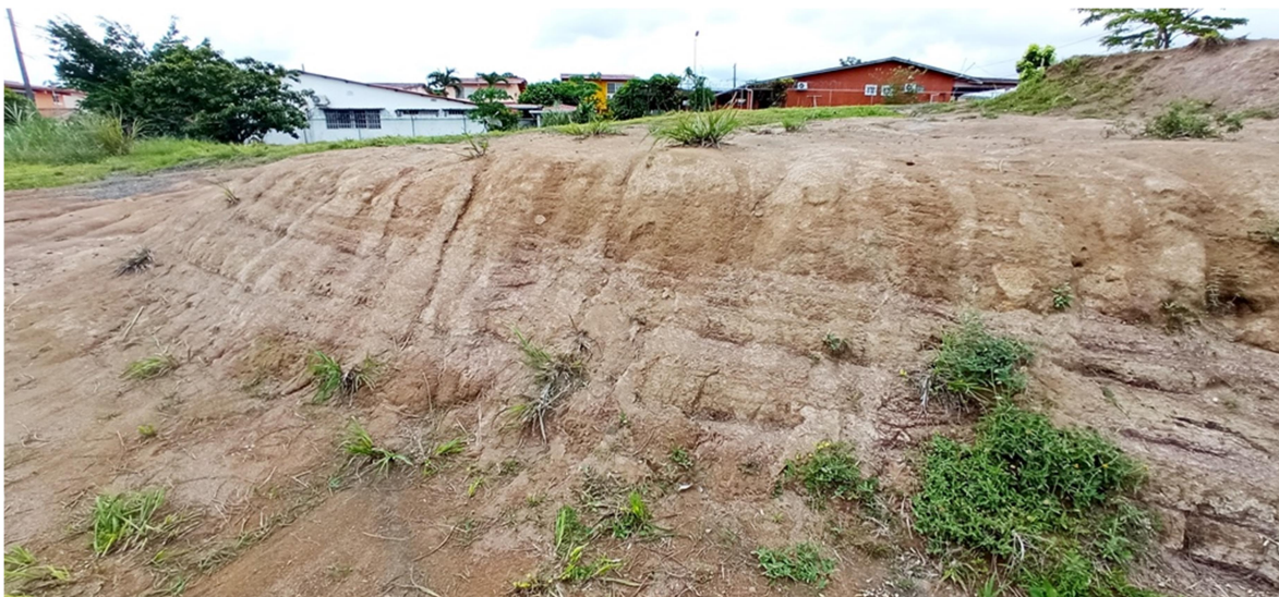
Fotografía 8 Erosión en la pared del talud
