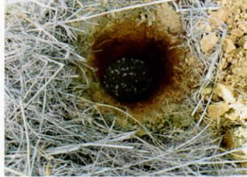
EXCAVACION DE 60CM DE PROFUNDIDAD POR 30CM DE DIAMETRO
