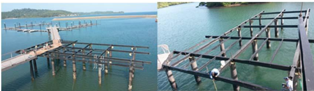
Figura 5: Sistema Fijación Plataforma Fija Mirador
