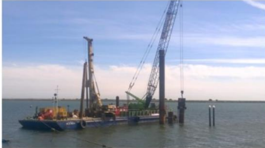
Grúa pluma en pontona instalando camisas metálicas
