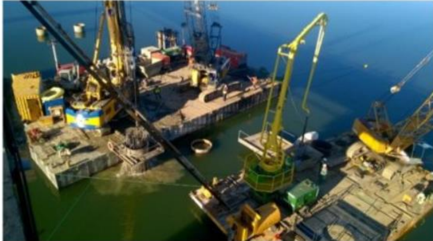
Hormigonado de pilotes acuáticos desde pontonas
