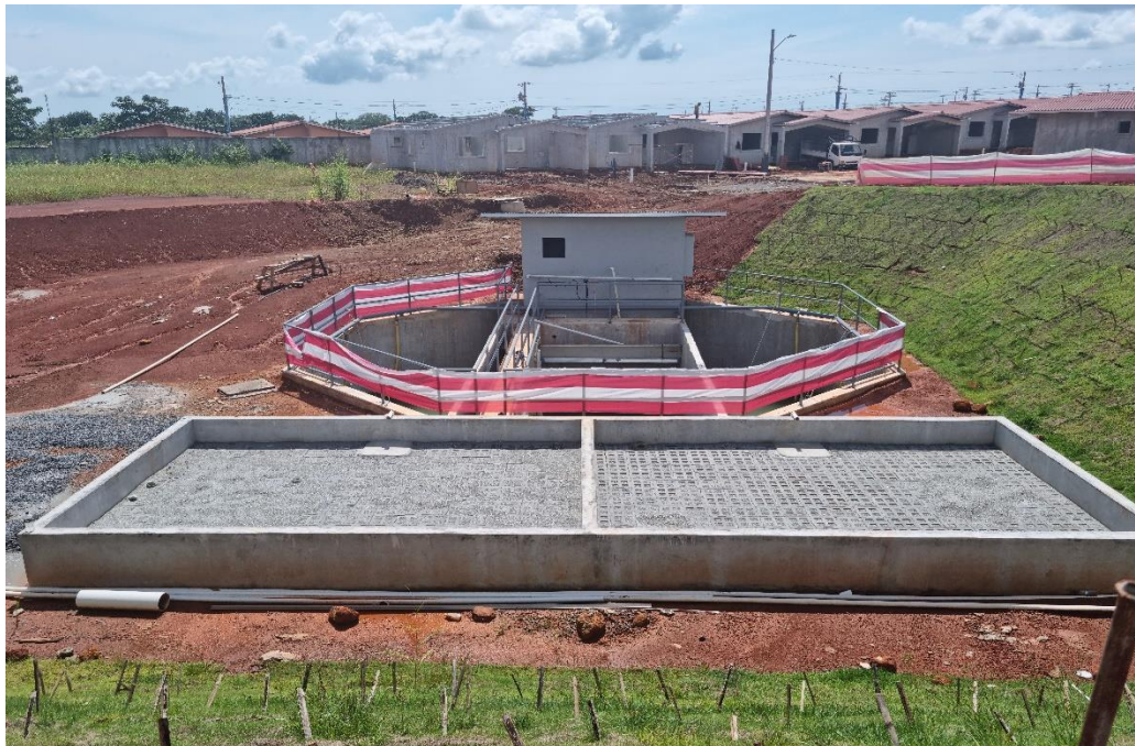
Fuente: Archivo de Equipo Consultor del EsIA Figura 22. Sistema de la PTAR construido en proyectos cercanos
