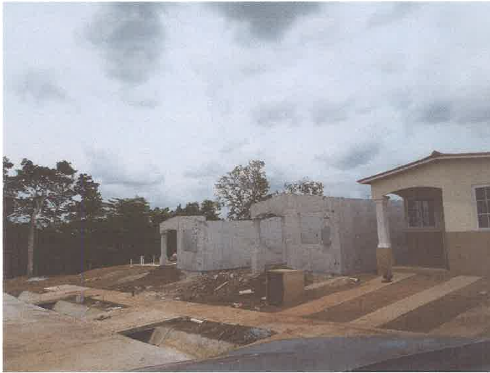
Sistema constructivo con moldes de aluminio que permite la construcción de las casas en menor tiempo.
