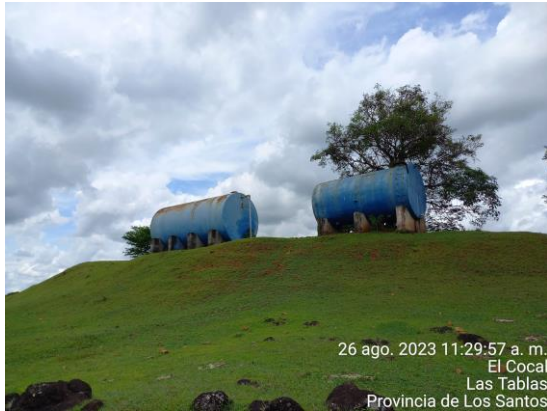
Tanque de metal existente de 20,000 galones.
