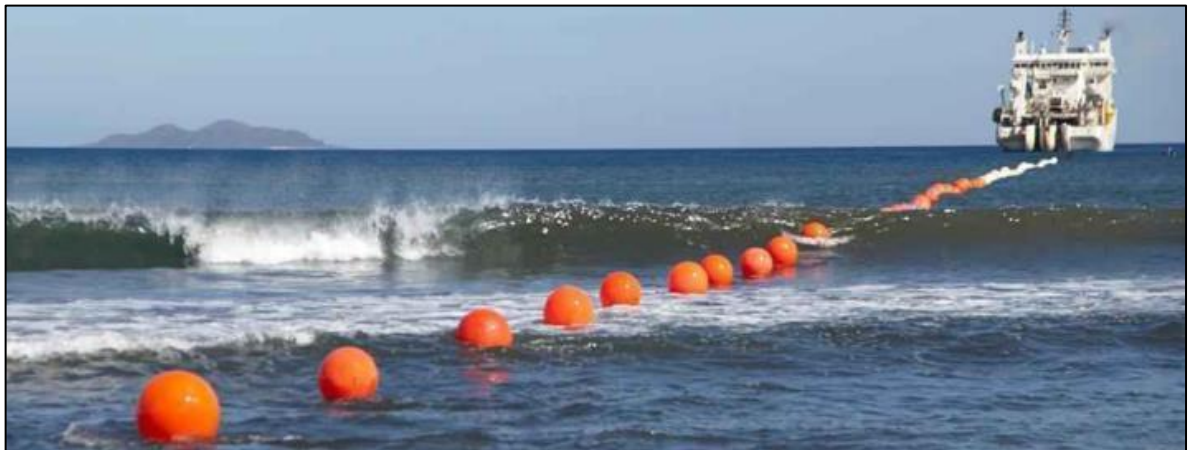
Ilustración 6: Vista referencial de la operación de aterrizaje de un cable submarino de fibra óptica
