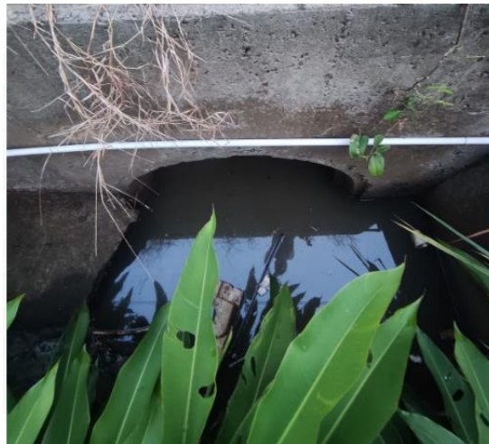
figura: 11 Aguas Debajo de Alcantarilla existente debajo de vía pública principal
