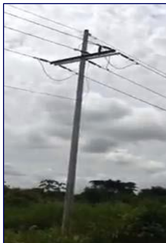
Figura 5-7. Apoyo de amarre en la línea existente.
