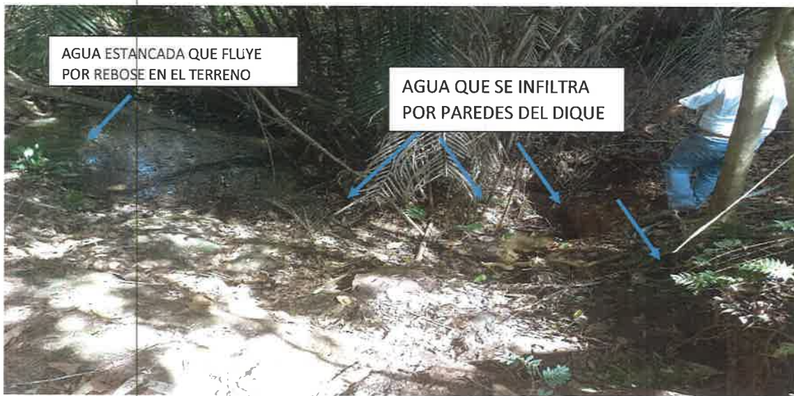
Foto 12. Agua fluyendo por la pared del dique de contención construido por el propietario anterior.
