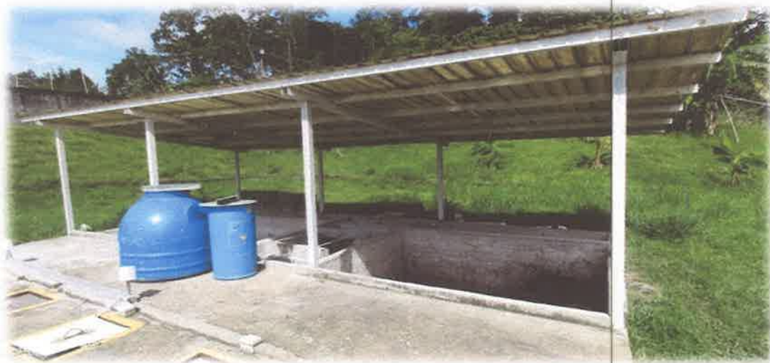
Fotografía 1 Ejemplo de eras de secado
