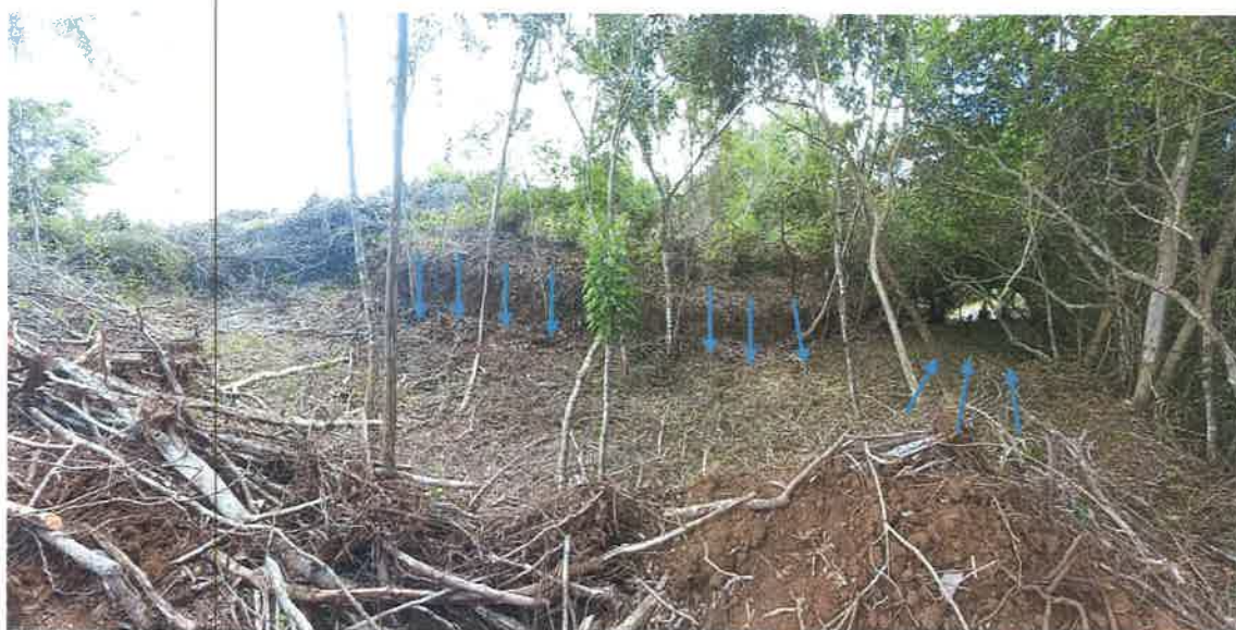
Foto 8. Corte de material que se empujó con máquina para construcción de dique.
