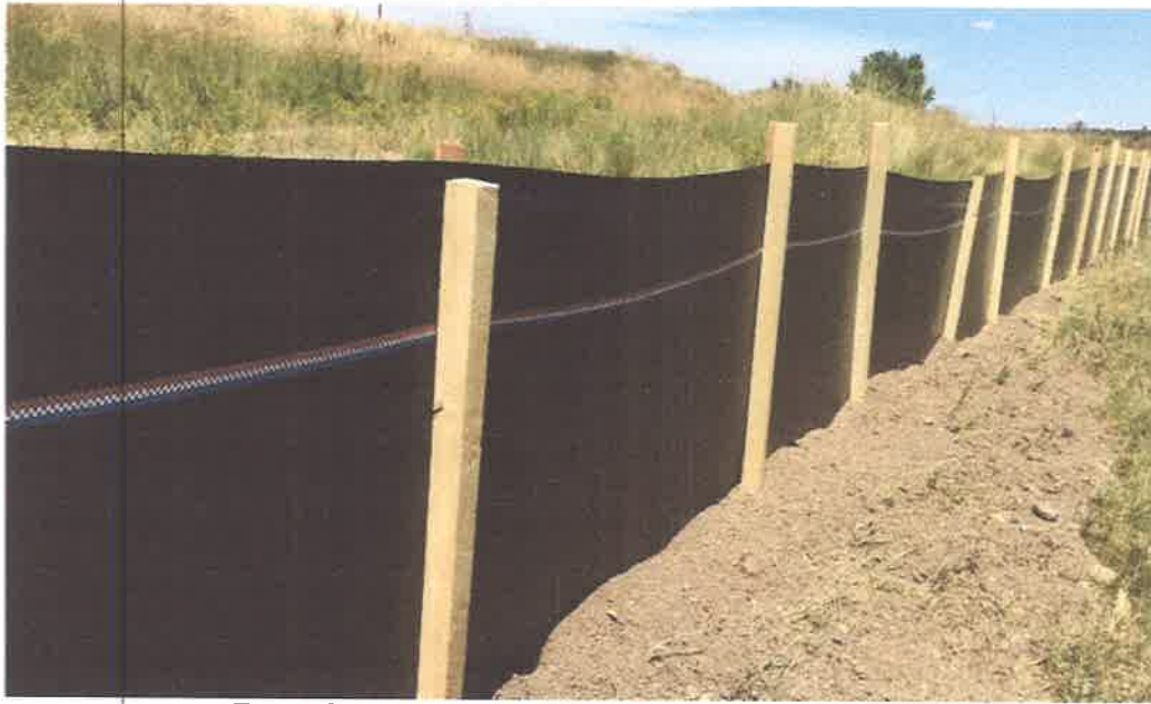
Fotografía 1 Malla para retención de sedimentos ( Silt Fence )
