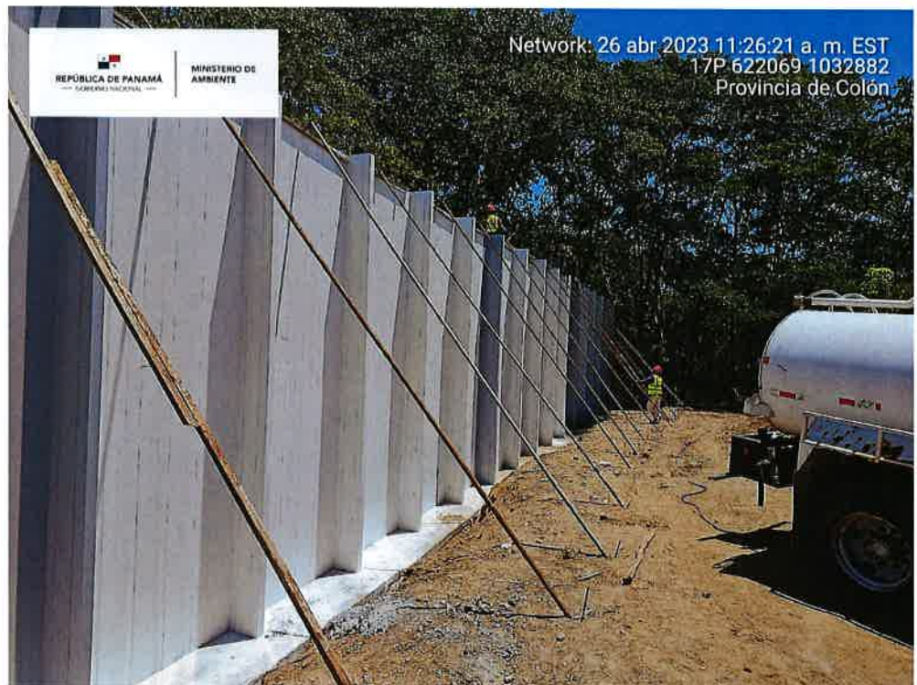
Figura 8. Trabajos de construcción ( levantamiento de muro con pvc relleno ), muy cercanos a la zona costero marina del sector de Atlantic Plaza-4 Altos.
