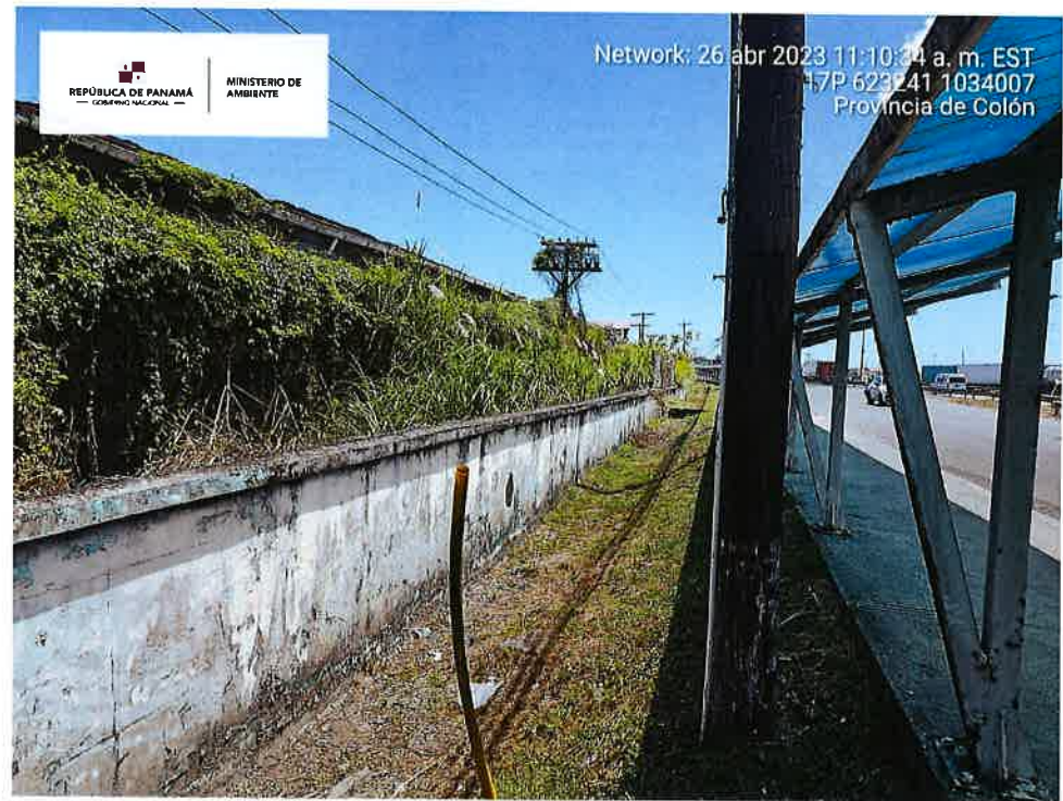
Fotografía 6. Punto intermedio del alineamiento contiguo a la vía Randolph, aquí se harán trabajos de levantamiento de altura del muro existente.
