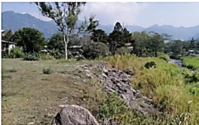
Figura 8.- Vista del muro de contención de piedra construido después de las inundaciones de 2008.
