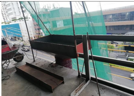
Foto 2 Chuta para disposición de desechos
