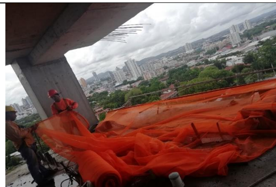
Foto 3 Se colocan bayas para protección de escombros
