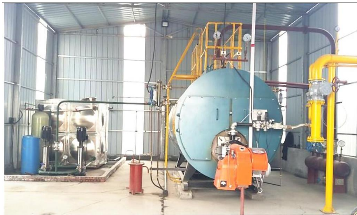
Ilustración 2: Imagen informativa de la caldera en estudio compartida en el catálogo del fabricante. No representa condición real en el proyecto.
