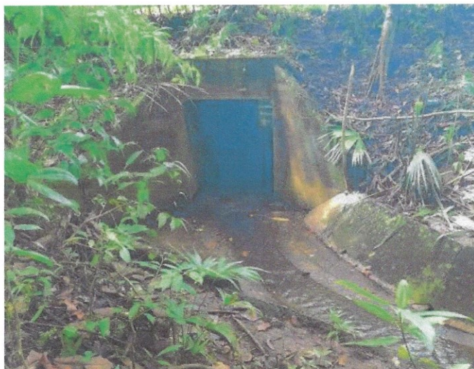
Foto 2: Vista de la alcantarilla de cajón de 1.50m x 1.80m en la Ave. Clayton
