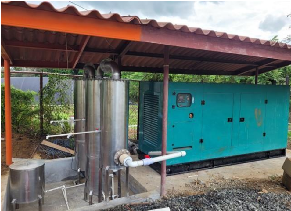
Foto 1. Ejemplo de un Generador funcionado a Biogás, Los Santos, Panamá. Sistema de Biodigestor y generador Instalado por Ing. Juan R Carrasco. Los Santos, Panamá 2024. c. Indicar cómo será el manejo de los lodos en las lagunas de oxidación.
