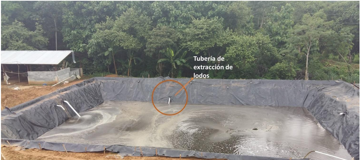
Foto 2. Tubería de extracción de lodo. Foto propiedad de Juan Raúl Carrasco
