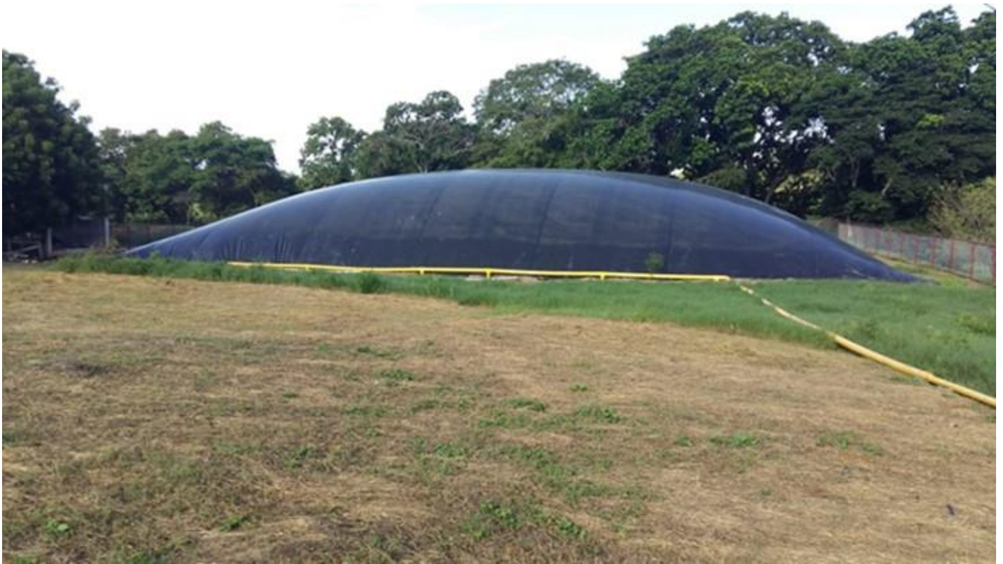
Foto 1. Sistema de Biodigestor Lagunar. Fuente, JRC CONSULTORES, S.A. (Ing. Juan Raúl Carrasco),
