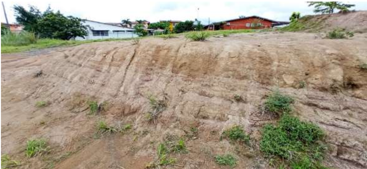
Fotografía 7 Erosión en la pared del talud
