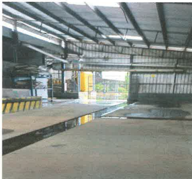
Ilustración. Cárcamo perimetral al interior de la bodega. Fuente propia
