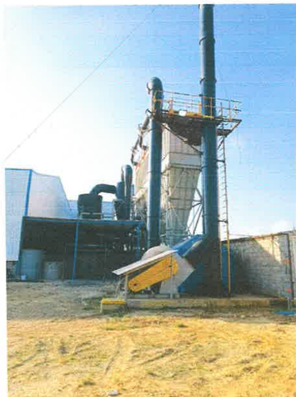
Ilustración. Sistema de control de emisiones para horno rotatorio.
