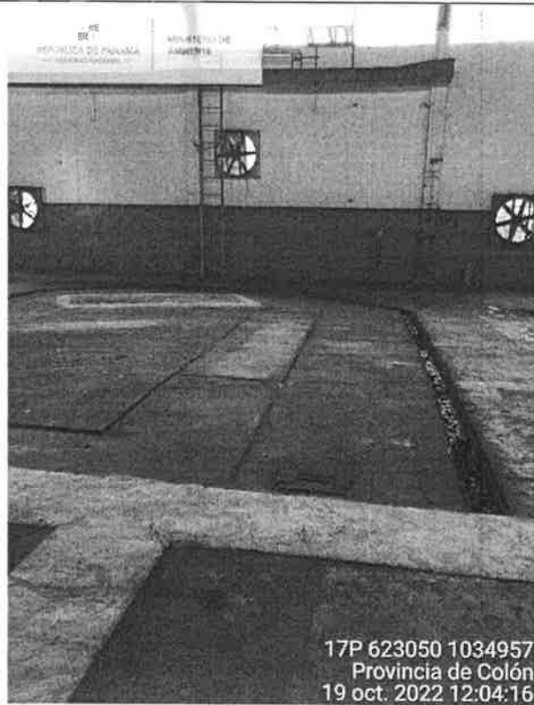
Foto 5. Drenaje existente en el piso de la galera
