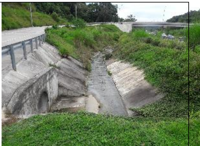
Figura No 6.25. Foto de estructura hidráulica señala por donde las aguas pluviales del desarrollo Foresta Norte incluyendo el Campus Gorgas se evacua por el sistema hidráulico de drenaje pluvial que corre desde su parte más alta paralelo a la Vía Centenario hacia los lagos cerca de la Vía Omar Torrijos. D. Arauz 2018
