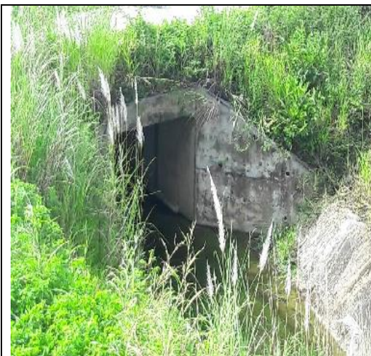
Figura No 6.24. Foto de Alcantarilla de cajón que forma parte del sistema hidráulico de drenaje pluvial de La Foresta Norte. D. Arauz 2018
