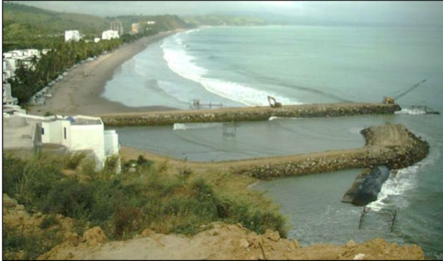
Imagen No. 2 Ejemplo de adecuación de Marina con instalación de geotubos
