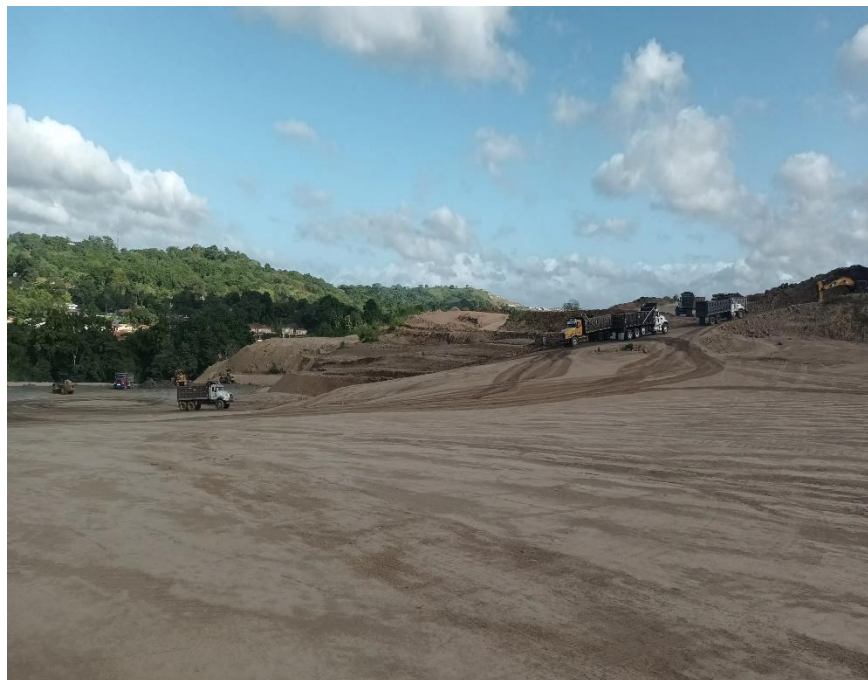
Figura 30. Vista de trabajos de nivelación de terreno
