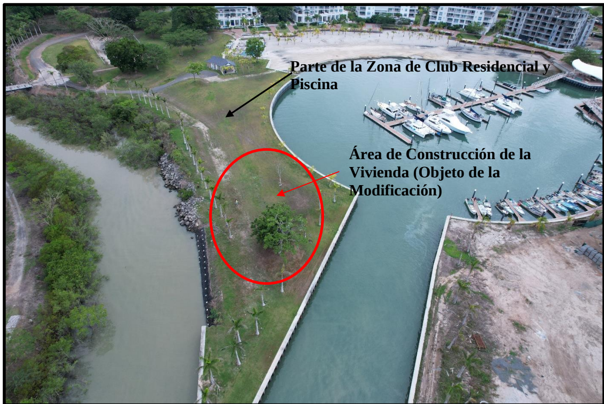
Figura#1. Vista del área donde se construirá la vivienda unifamiliar. Fuente: Equipo Consultor.
