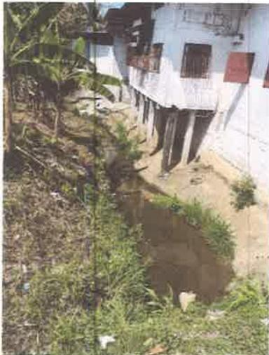
**Foto 3 Cajón 0+045 con presencia de agua**
