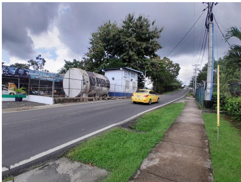
Figura 23. Tanque de agua potable de 15,000 galones
