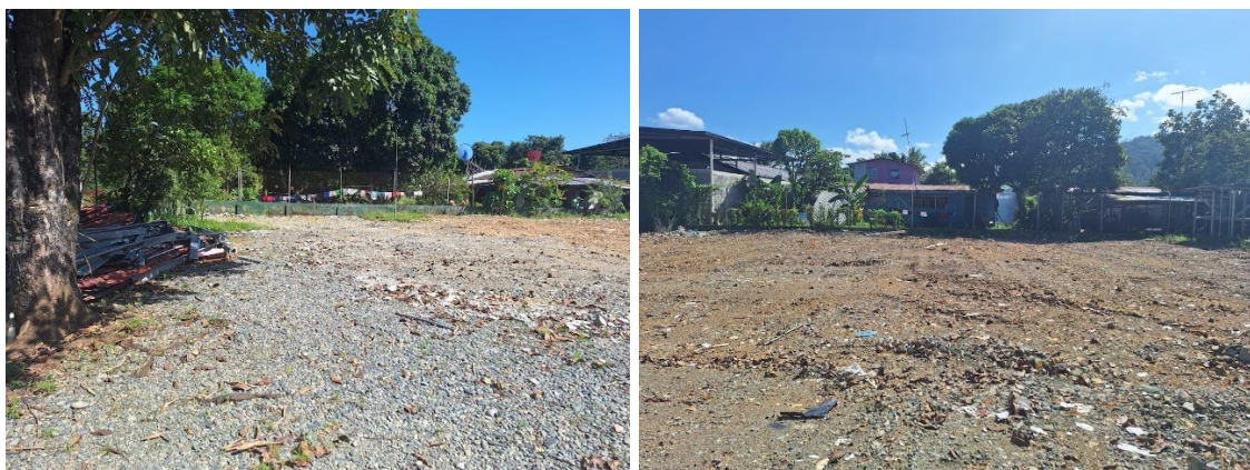
Figura 3.- Vista del área a intervenir, la estructura previa ya fue demolida y solo queda el predio cubierto de material.
