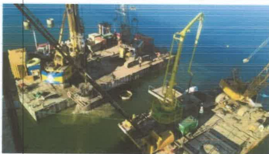
Hormigonado de pilotes acuáticos desde pontonas
