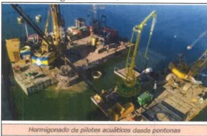
Imagen#2. Vista de la maquinaria a utilizar para el proceso de construcción de las estructuras. Fuente: Respuesta a la segunda información aclaratoria.
