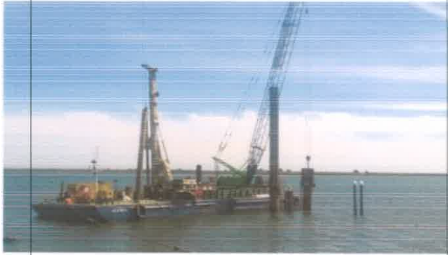
Grúa pluma en pontona instalando camisas metálicas
