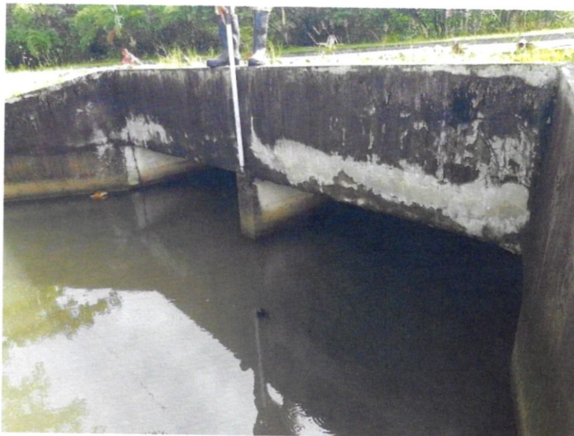
Foto No.1: Vista de la alcantarilla de cajón doble de 2.15m x 1.50m que llega a la Parcela A101-03A (sector de Arco Iris).
