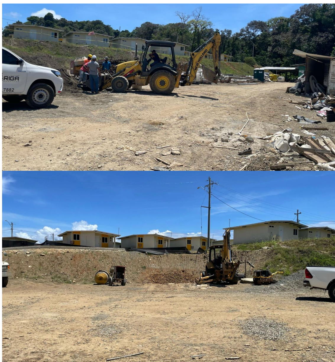
Fig. 4.- Vistas del área donde se desarrollará el proyecto: nótese que el suelo está nivelado y compactado.
