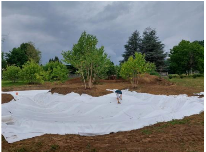
FASE 2: INSTALACION LAMINA GEOTEXTIL
