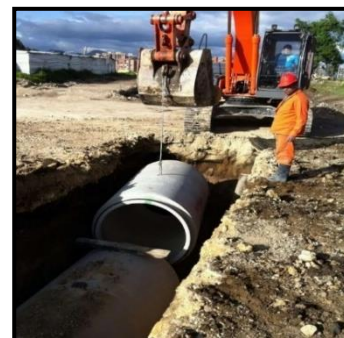
Imagen 2. Colocación de tubería de hormigón reforzado.
