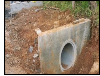
Imagen 5. Construcción de cabezales.
