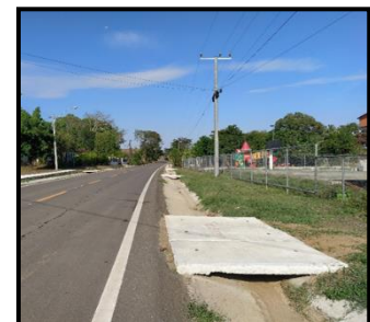
Imagen 4. Construcción y colocación de losas de hormigón reforzado para entradas peatonales y vehiculares.
