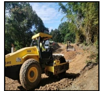
Imagen 6. Conformación de calzada.
