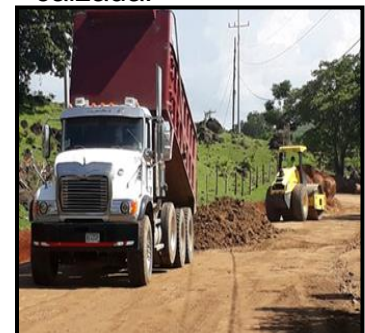
Imagen 7 Colocación y compactación de la sub base.
