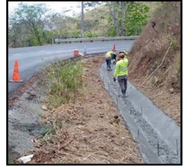
Imagen 3. Construcción de cuneta pavimentada trapezoidal.
