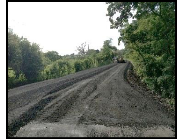
Imagen 8. Colocación de capa base.
