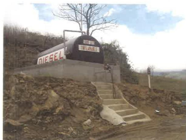
TANQUE DE COMBUSTIBLE DIESEL SEGÚN NORMA DEL CUERPO DE BOMBEROS DE PANAMÁ
