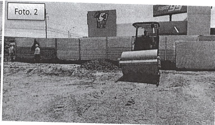
Foto 1 y 2: Maquinaria pesada laborando, acero que ya están cortando en el sitio, y Máquina compactadora en labores de nivelación y compactación.
