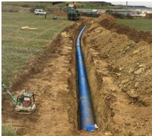
Imagen N°6: Esquema apertura de zanjas para instalación de tuberías
