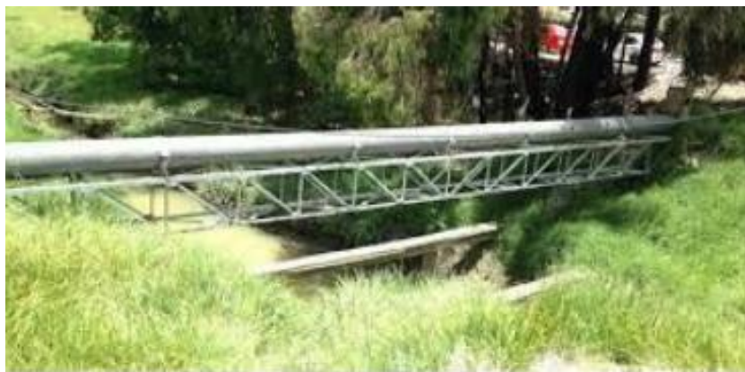
Imagen N°7: Cruces área en caso de cuerpos superficiales en el alineamiento de la tubería
