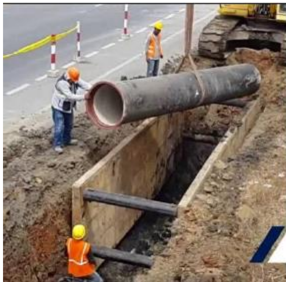
Imagen N°6: Esquema apertura de zanjas para instalación de tuberías
