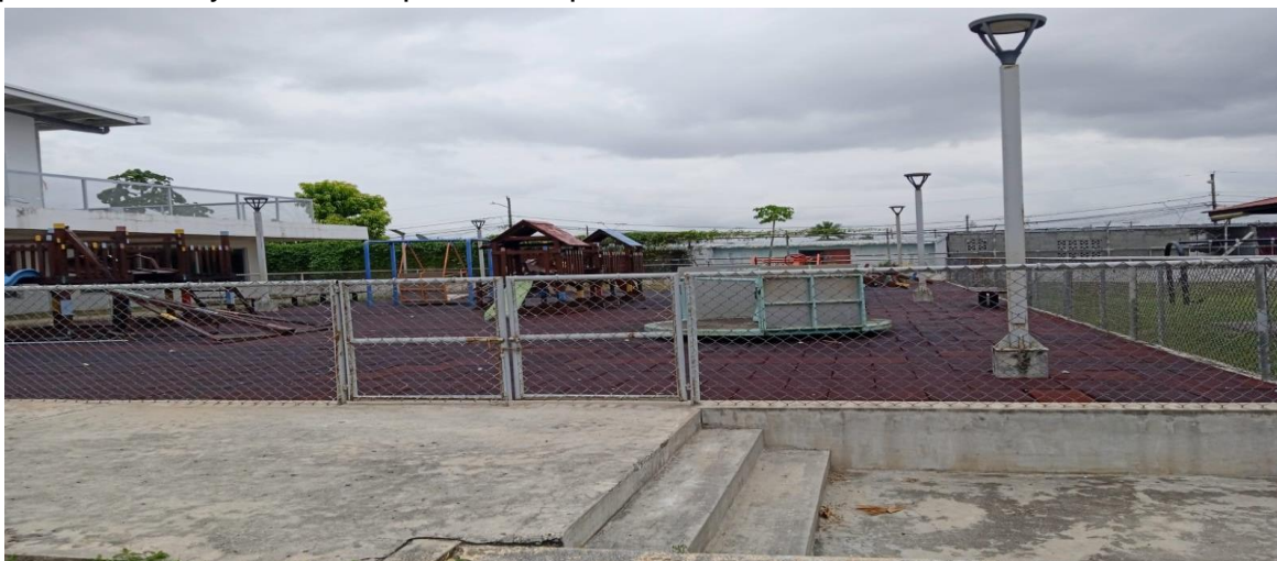
Imagen 2. Suelo pavimentado y recubierto por baldosas de caucho.
