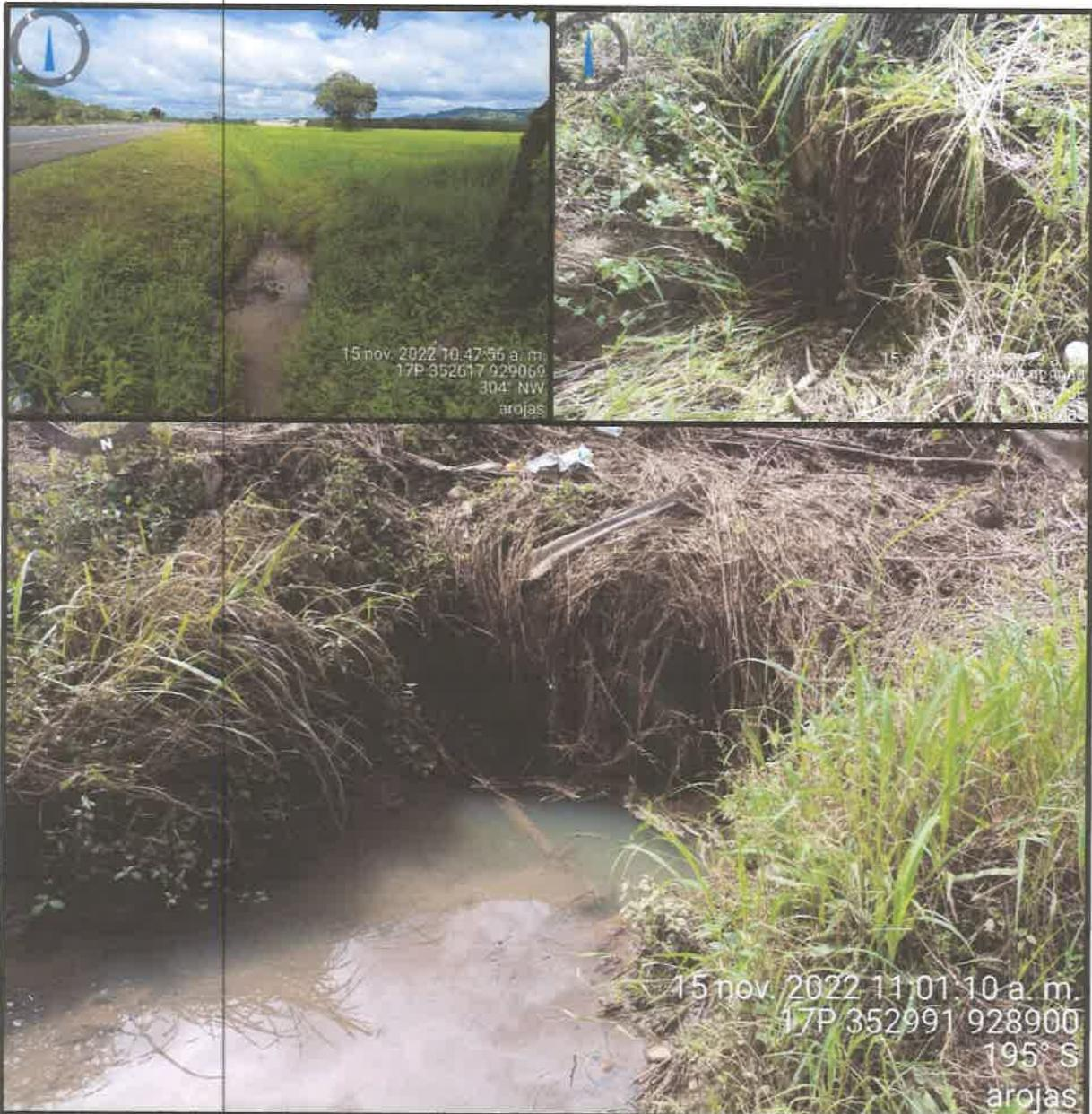
Figura 8- Vista del estado de cunetas y alcantarillas que se encuentran en la vía Panamericana y donde se mencionó durante la inspección que podrían ser una alternativa para conducir el agua de escorrentía provenientes del proyecto RESIDENCIAL SANTA RITA. noviembre 2022. Fuente: arojas
