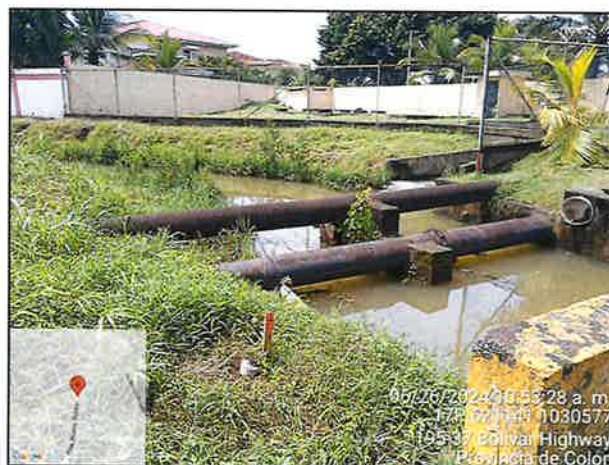
Ilustración N° 6 Tuberías paralelas al Puente Brazo Brook #1.
