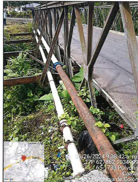
Ilustración N° 2 Tuberías sobre el Puente El Polvorín.
