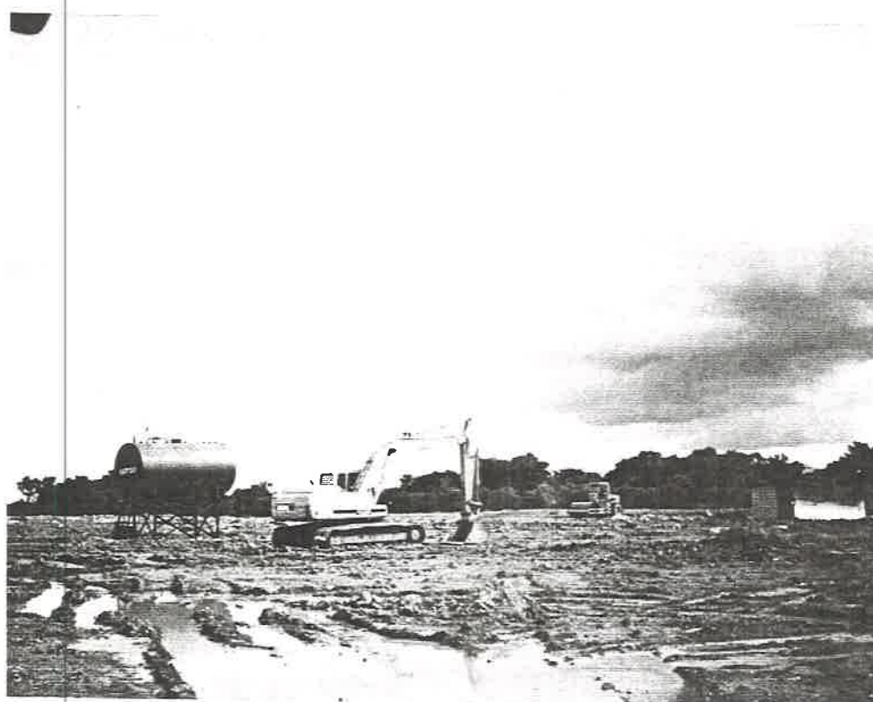
Foto No. 3.11: Pala mecánica actualmente en uso en el proyecto. Observar el tanque de combustible y al fondo una rola compactadora.
