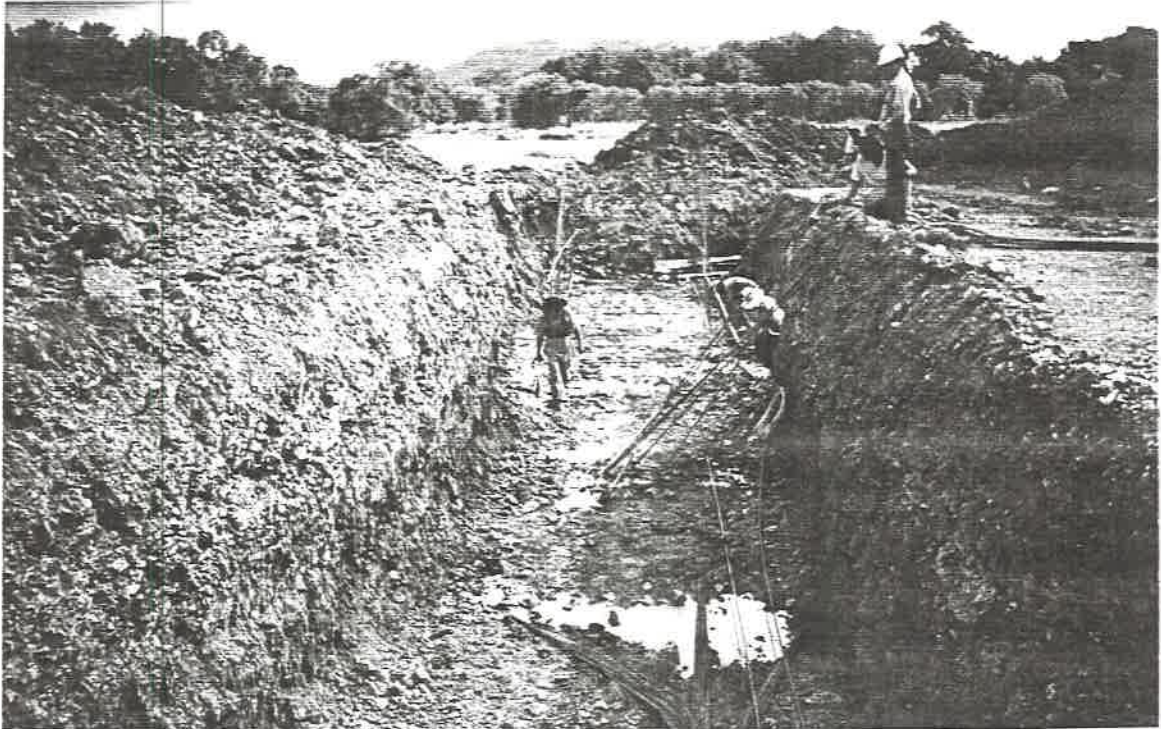
Foto No. 3.5: Excavación y colocación de acero de refuerzo en la alcantarilla de cajón que quedará debajo de la pista principal en el tramo recto. Foto tomada el 11.11.00.
