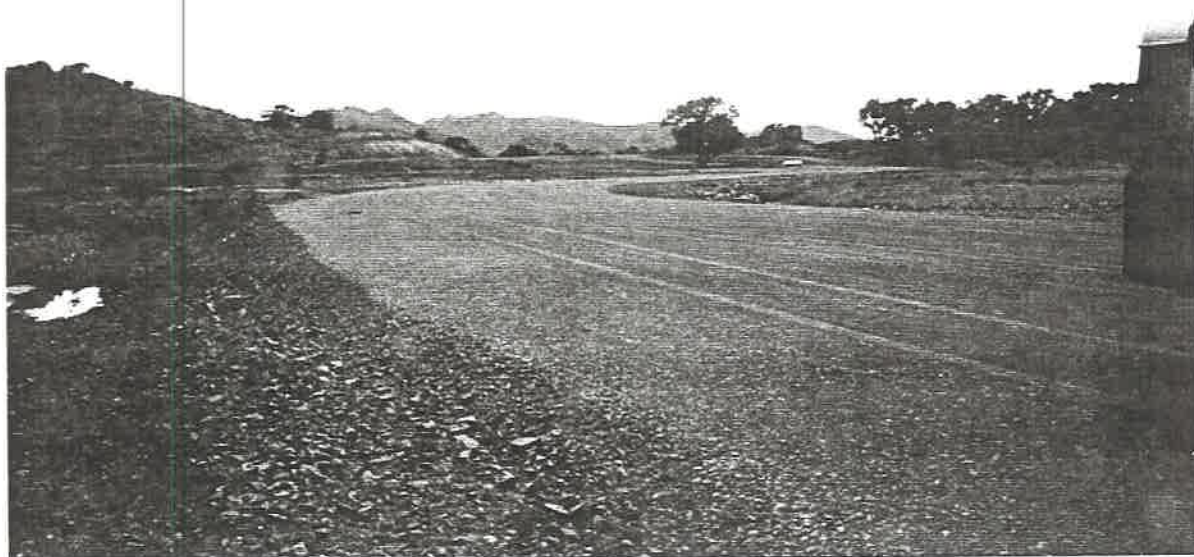
Foto No. 3.6: Situación actual de la base de la autopista principal, lista para imprimación y colocación de carpeta asfáltica. Foto tomada el 11 de noviembre de 2000.
