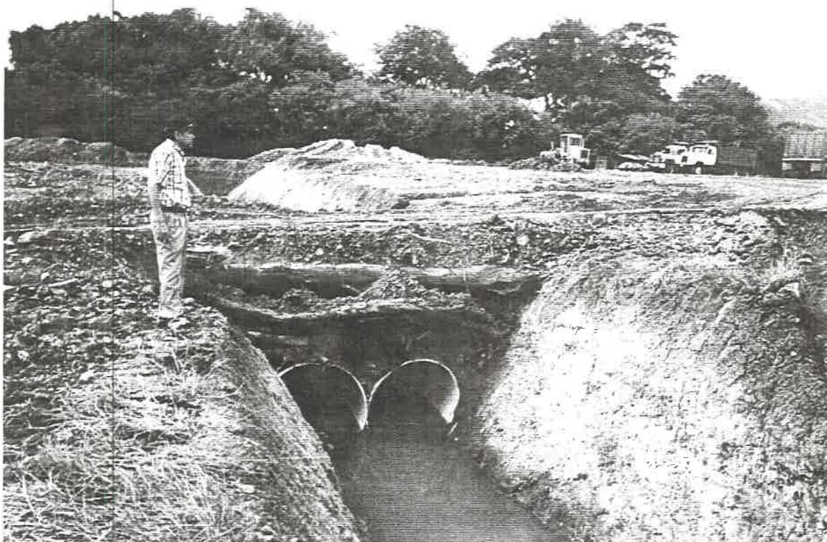
Foto No. 3.8: Canal No. 1A del sistema Pluvial, paso provisional para permitir el tránsito de equipos y maquinarias durante la construcción.
