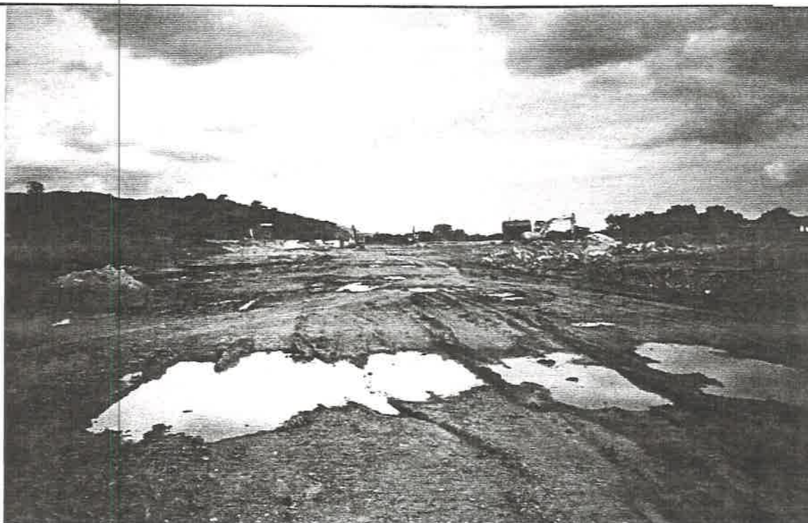
Foto No. 2.1: Lodazal formado después de un fuerte aguacero en la subbase de la pista principal en el tramo recto. A pesar de las precauciones siempre se producen lodazales. Foto tomada el 11.11.00.
