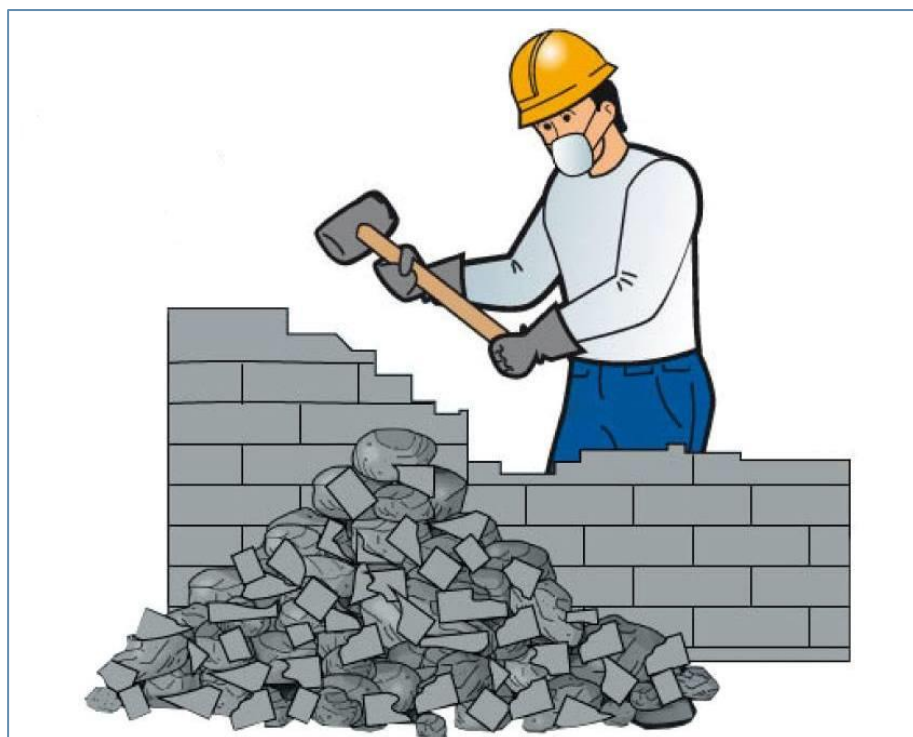
Figura 4-1. Imagen ilustrativa de demolición manual de paredes
