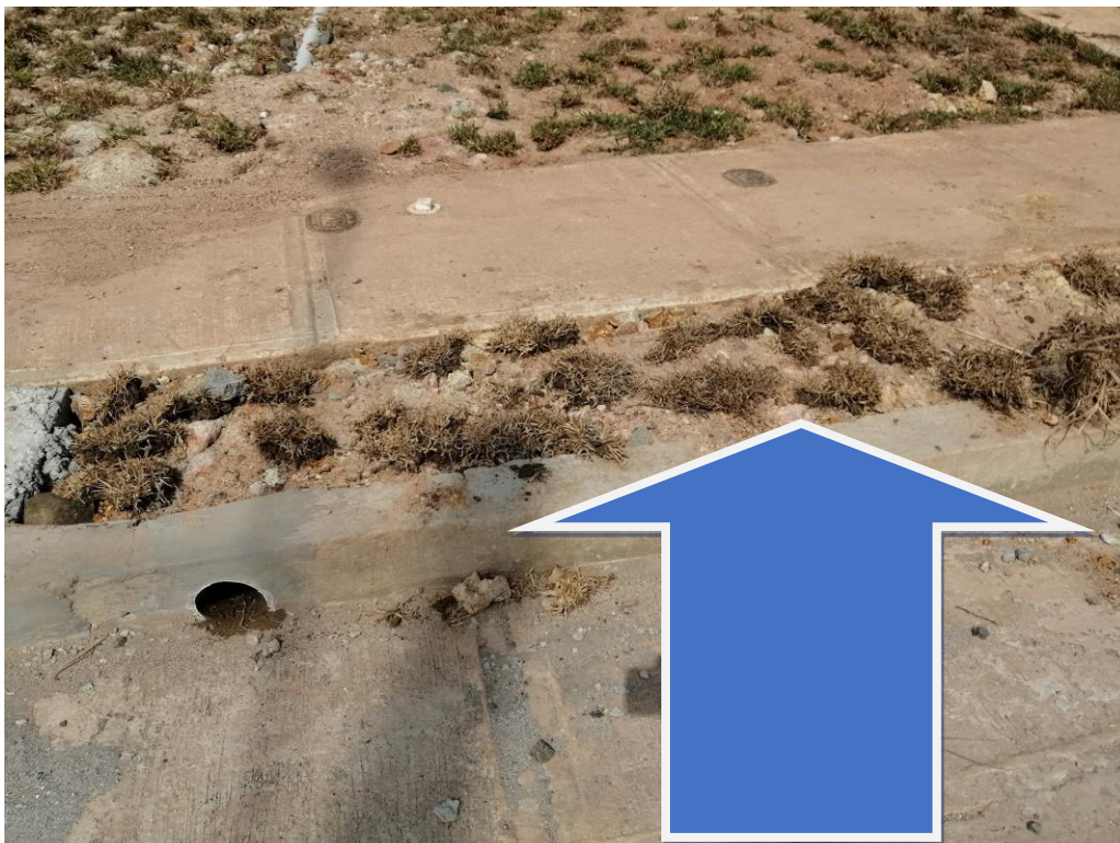
TRAGANTES DE AGUAS PLUVIALES Y GRAMA INSTALADA
