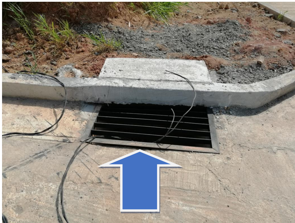
SISTEMA DE ALCANATRILLADO Y TRAGANTE DE AGUA PLUVIALES
