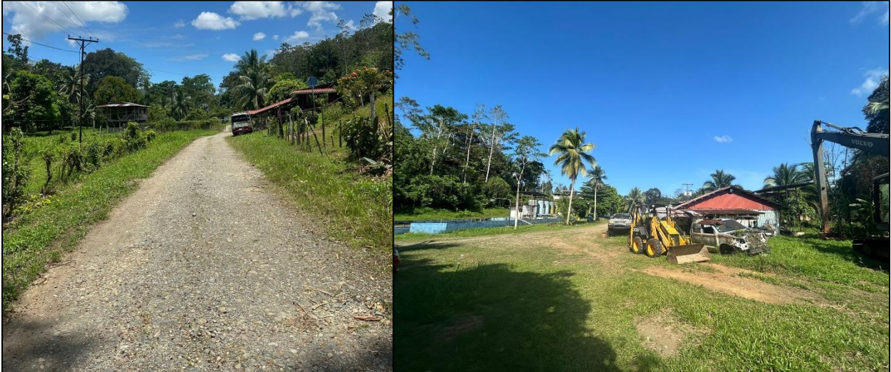
Figura 40. PTAP - Quebrada Nigua.
