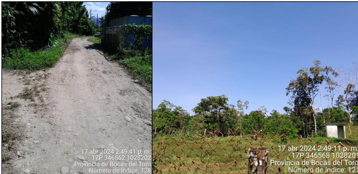
Figura 38. Tanque de Almacenamiento de Agua Potable - Las Vegas.
