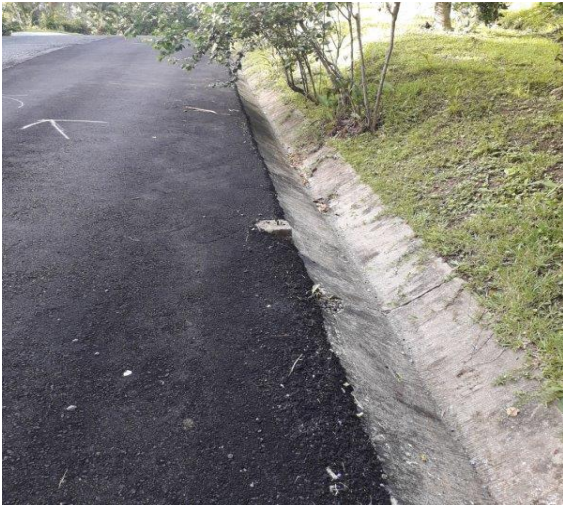
Característica de las cunetas y zampeados construidos como parte de la infraestructura pluvial adyacente a las vías.
