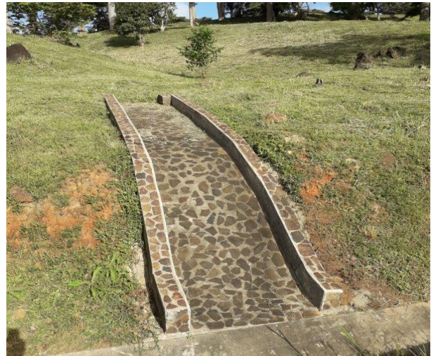
Característica de las cunetas y zampeados construidos como parte de la infraestructura pluvial adyacente a las vías.
