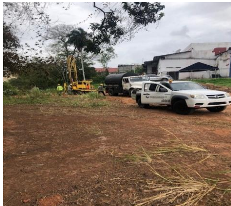
Foto No. 4.6. Equipo y personal preparando para la perforación del estudio de suelos.
