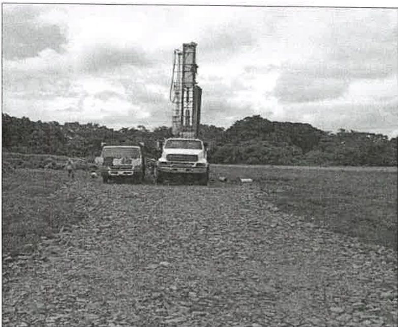
Imagen 1, 2. Punto de encuentro para verificar en campo, recorrido del proyecto en proceso de evaluación, equipo de perforación de pozo realizando pruebas de agua, la topografía del sitio es irregular a plana, con algunas ondulaciones.
