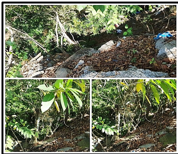
Imagen No 3: Conformación de talud colindante con la servidumbre del rio Aguacate/Burunga con materiales tipo caliche, compactada en años anteriores.
