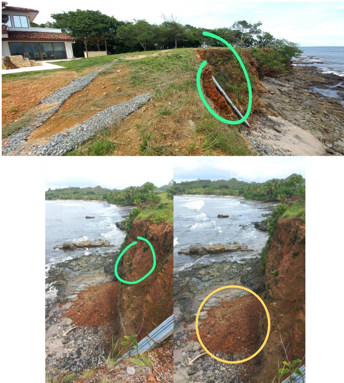
**Imagen 3. Evidencia de la pérdida de suelo por la erosión causada por el golpe de las olas en mareas altas, aunado a las fuertes lluvias de la temporada y frentes fríos.**
