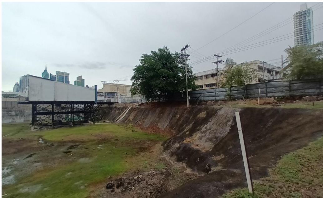
Figura 10. Taludes de contención perimetrales del proyecto
