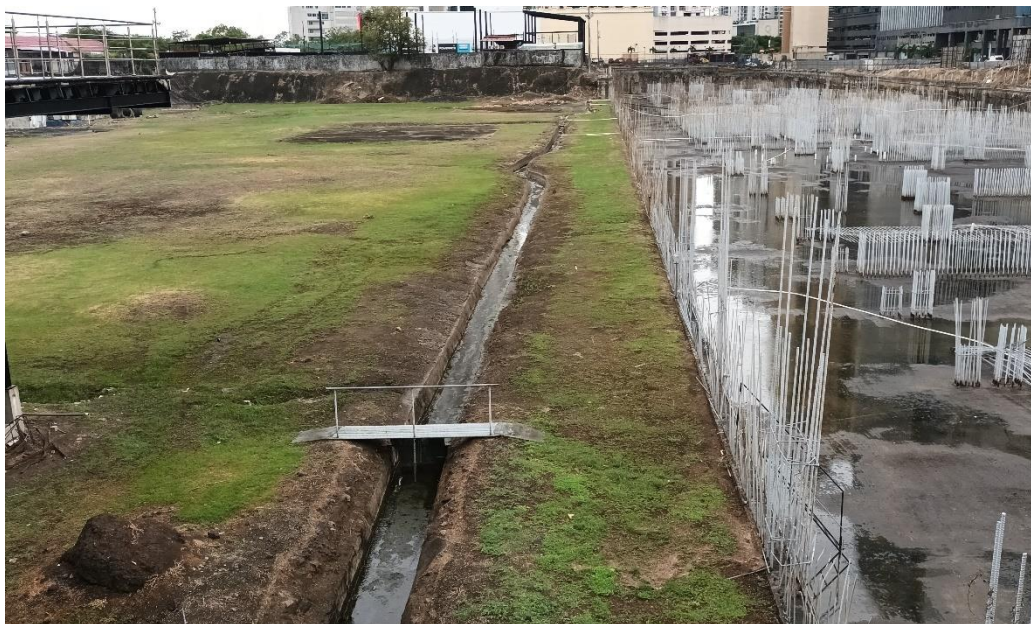
Figura 8. Canales abiertos existentes para drenaje de agua pluvial
