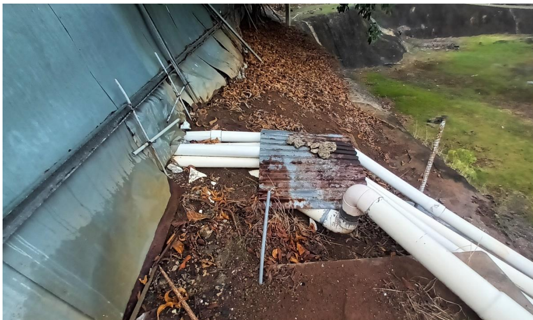
Figura 22. Tuberías pluviales existentes a la salida del polígono
