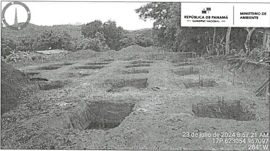
Imagen 4. Al momento de la inspección, se observó que el promotor había iniciado con la excavación del cimentado de columnas del edificio, por lo que se les indicó que no se continuará con los trabajos, hasta culminar el proceso de evaluación del EsIA. Fuente: Imagen de la Inspección realizada el día 23 de julio de 2024.
