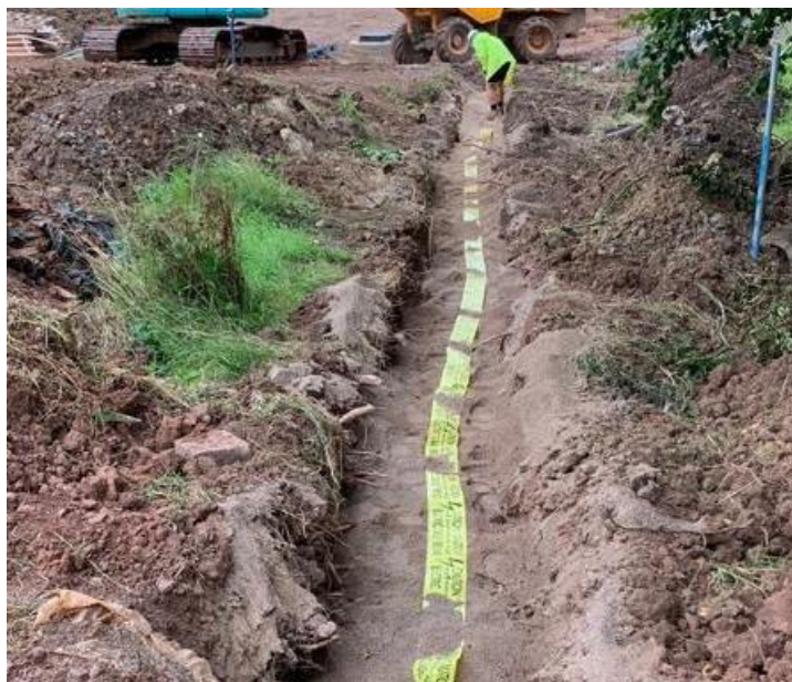
Ilustración 13 - Instalación de Cinta de Precaución
