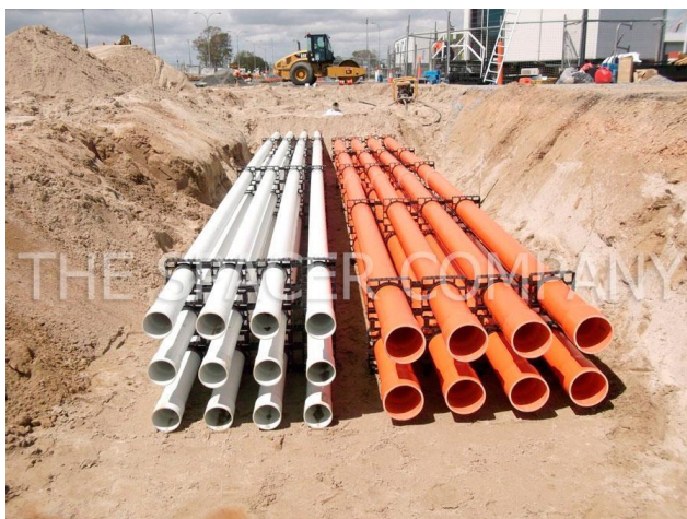
Ilustración 10 - Colocación de Espaciadores en Zanjas
