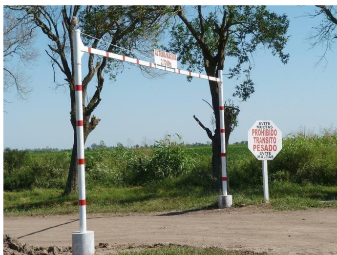
Ilustración 2 - Ejemplo de limitador de Altura
