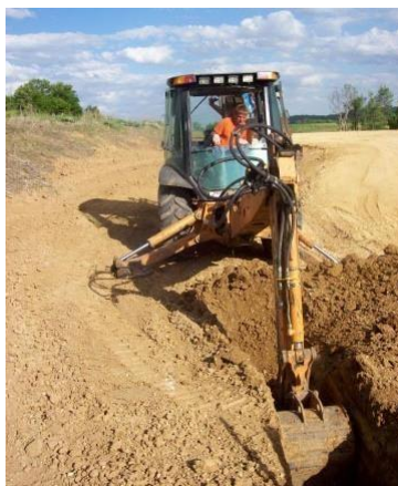
Ilustración 9 - Retroexcavadora excavando zanja
